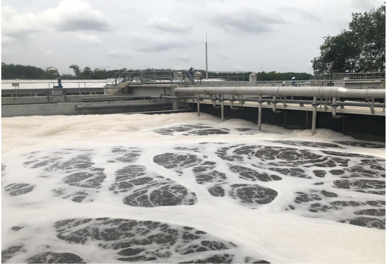
Hình ảnh cụm xử lý nước thải của Công ty TNHH chăn nuôi Hòa Phước
